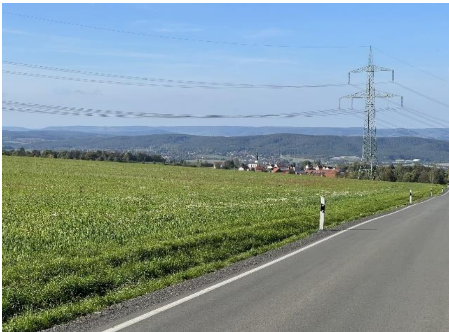
Blickrichtung Süd auf Ortslage Gertewitz
