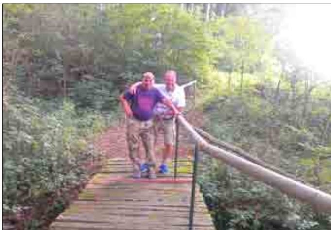
einen Handlauf zur Brücke, reparierte die Brücke
