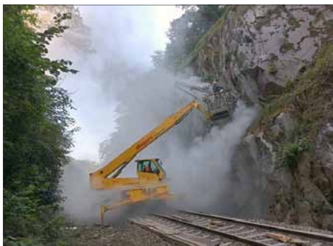
Vorbereitungsarbeiten (22.05.2018): Bohren der Löcher für das Einbetonieren der 2,50 m langen Stahlanker
