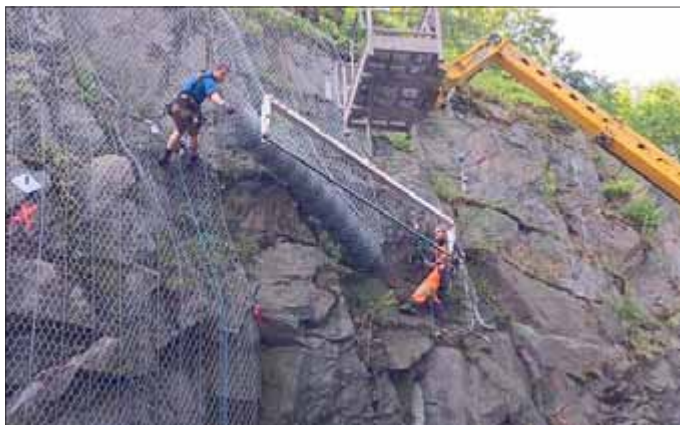
Ende Mai: Sicherungsarbeiten im Baubereich - Verspannen der Felswände mit verstärkten Stahlnetzen
