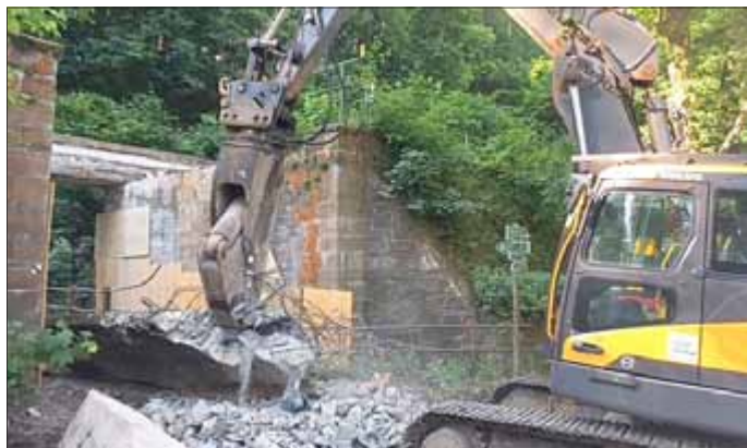
Hier werden die Brückenteile mit einem 20 t-Bagger zerkleinert.
