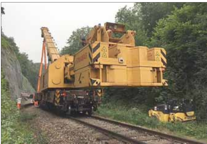
Nach dem Verlegen der Bahnschienen über die Schlagmühlenbrücke konnte dann am 11. Juni das 75 t schwere Betonbrückenteil für die Harrasmühlenbrücke mit einem 150 t tragenden Eisenbahndrehkran zur Baustelle transportiert werden.
