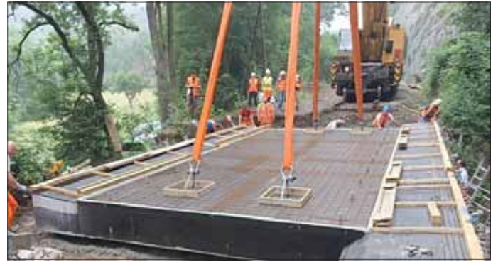
Der Überbau der Harrasmühlenbrücke wurde mit Hilfe des Eisenbahndrehkranes gesetzt.
