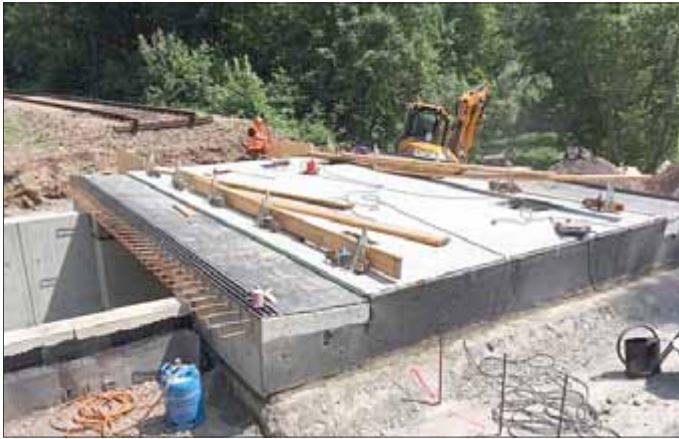
Der Überbau der Harrasmühlenbrücke wurde mit Hilfe des Eisenbahndrehkranes gesetzt.
