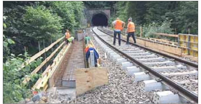
Nach dem Verlegen der Bahnschienen sind noch Arbeiten an den Randbereichen erforderlich.
